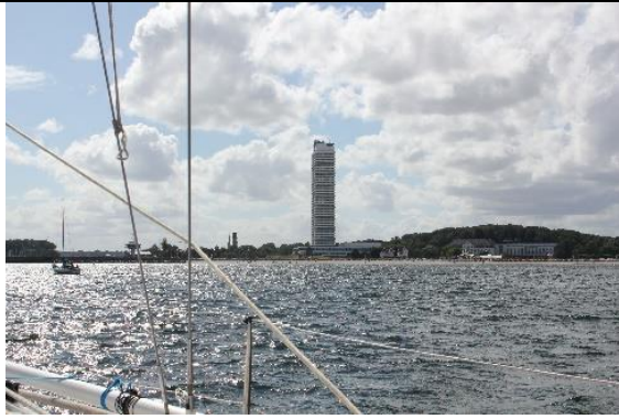
Wahrzeichen für die Ansteuerung von Travemünde
